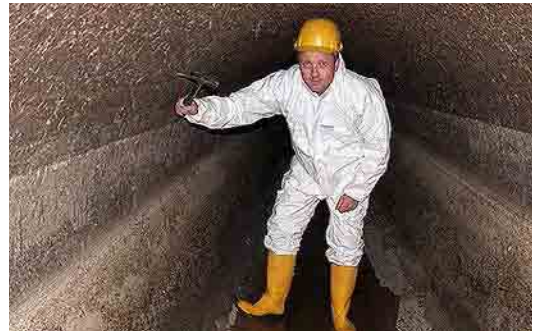
Begehbare Mischwasserkanal in Dörentrup
