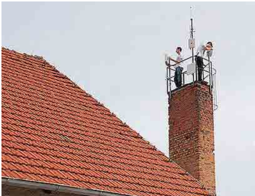
Hoch oben im Einsatz
