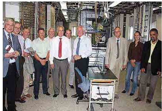
Gesellschafterversammlung in der Schaltzentrale
